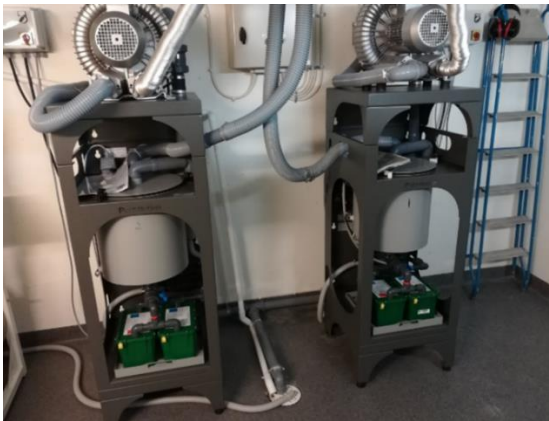
Exempel på nytt vått sugsystem (PureMotion) med sedimentterande amalgamavskiljning
