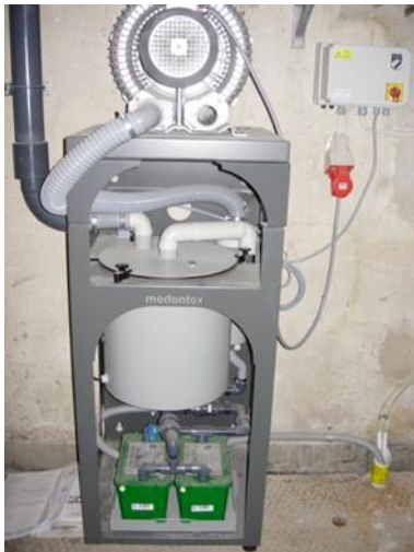
Ex på vått sugsystem med sedimenterande amalgamavskiljare
