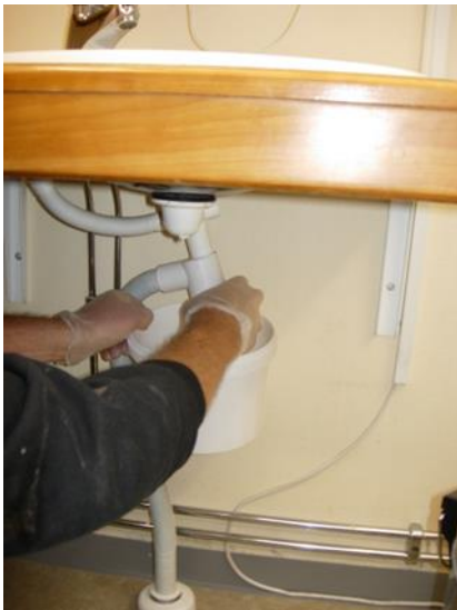
Rengöring av vattenlås
