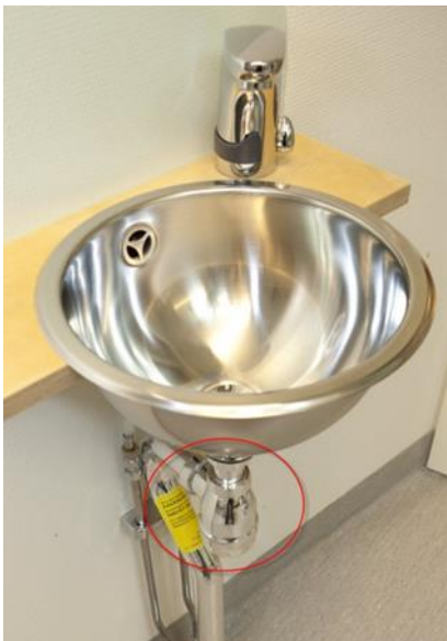
Vattenlås på tvättställ i behandlingsrum
