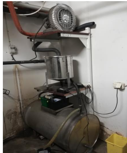
Exempel på äldre vått sugsystem (Flexsystem) med sedimentterande amalgamavskiljning.
